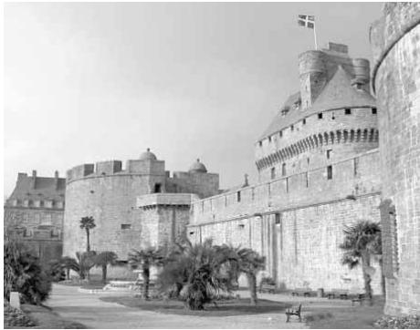
Figure 1 : La porte principale des remparts permettant l'accès à la cité corsaire intramuros
